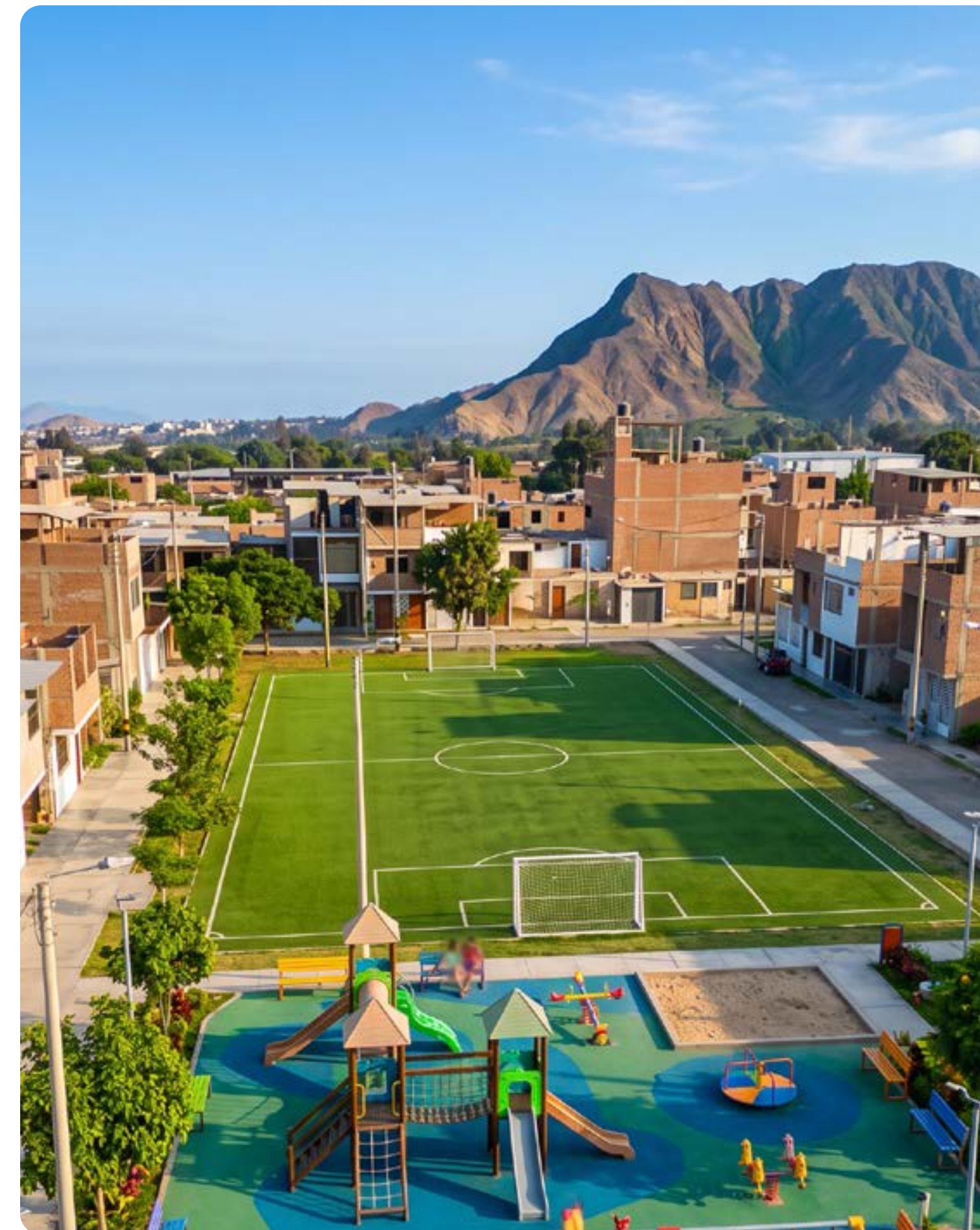
AMENIDADES EN CONSTRUCCIÓN
